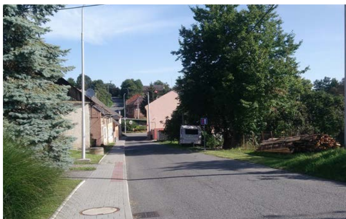
Zrekonstruuje se část úseku silnice od obecního úřadu v Troubkách po Zdislavice.
