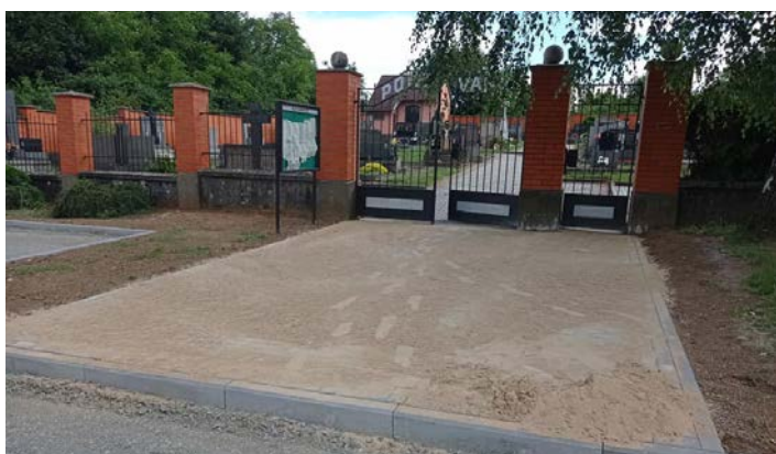
Nový povrch silnice je až ke hřbitovu ve Zdislavicích.
