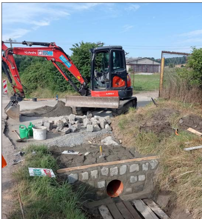
Rozšířil se most ve spodu areálu JZD v Troubkách a zvýšila se jeho tonáž. Tím se odlehčí nákladní dopravě v obci.
